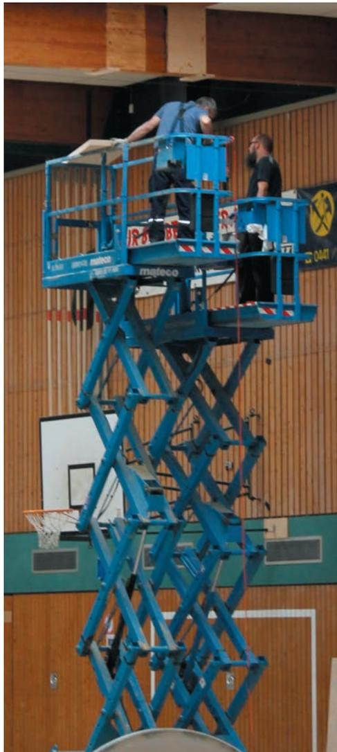
*Nur von einem Hubsteiger aus konnten die Holzleimbinder an der Decke der OTB-Sporthalle Haarenesch saniert und repariert werden. Dazu mussten auch die Heizlüfter abmontiert werden. Die Arbeiten in der Zwischendecke waren bei den hochsommerlichen Temperaturen für die Handwerker mehr als schweißtreibend.*
